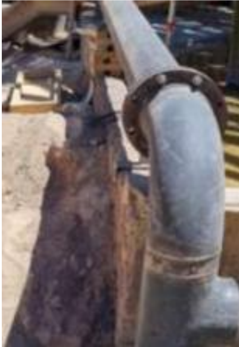
Montaje Red contra Incendios y Agua Industrial.
