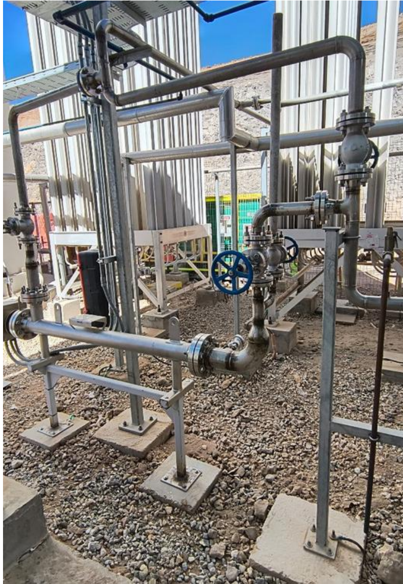
Montaje Calefactor Planta de Oxigeno
