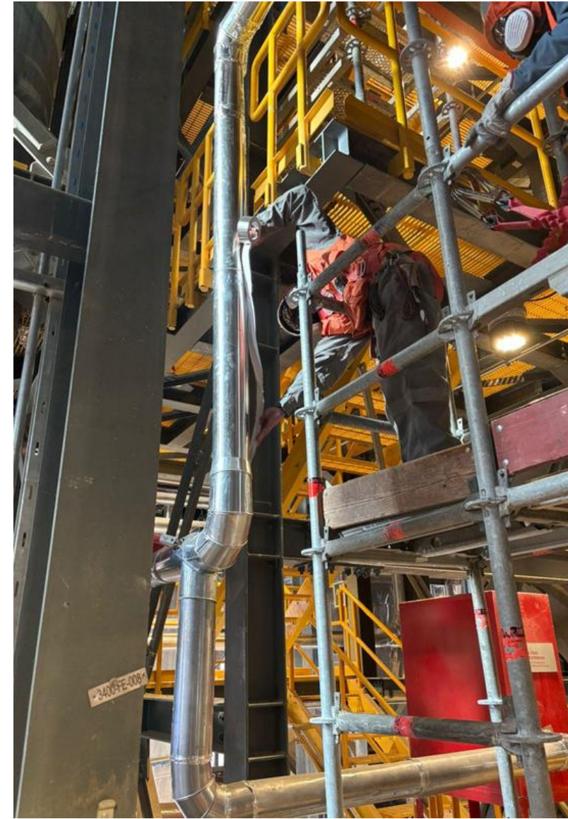
Montaje de Heat tracing y Aislación en Red Contra Incendios y Líneas de Proceso
